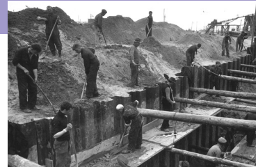
Bouw van de Atlantische muur © Bundesarchiv, Koblenz
